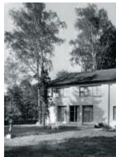
11 Die Villa Im Obersteg im Gellert, Basel
